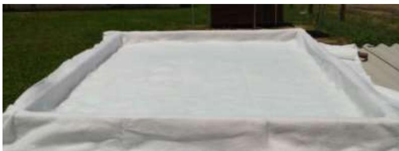
Figura 11: Camada filtrante manta geotêxtil.
